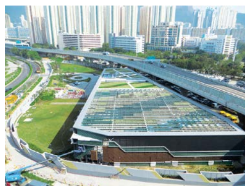
啟德發展區區域供冷系統
