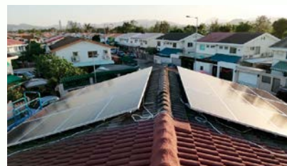
在上網電價計劃推出後，不少住宅的天台都安裝了太陽能發電系統
