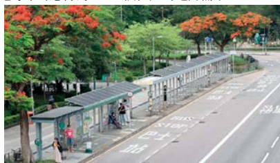
九巴及龍運在巴士站上蓋裝設太陽能裝置，為巴士站提供照明
